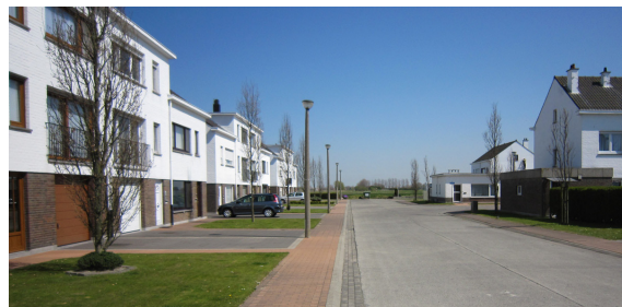
Foto: Gruttolaan + Talingpad: overwegend wit, met plint in roodbruine baksteen en zwart pannendak Foto's bron WVI
