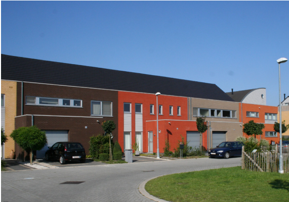
Foto: voorbeeld koppelbouw verholen goot. Bron: WVI
